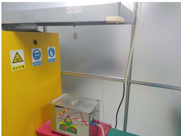
乙醇清洗废气收集措施
